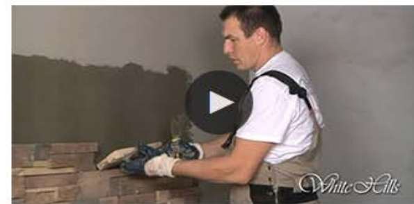
Укладка искусственного камня
