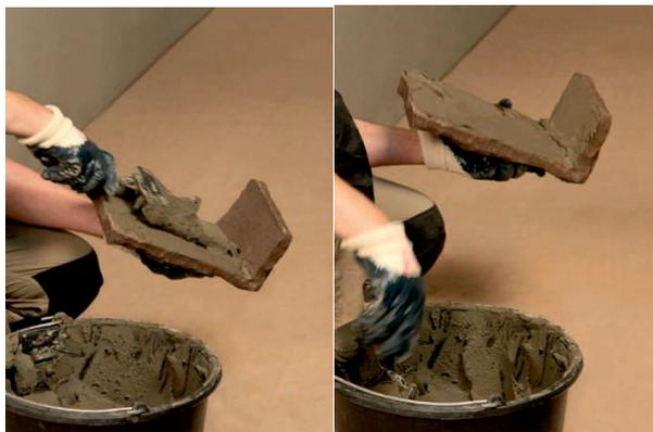
Крепко прижать камень к стене и слегка «подвигать» из стороны в сторону, чтобы обеспечить наилучшее сцепление. С умеренной силой надавить на камень или постучать по нему резиновой киянкой так, чтобы небольшое количество клея выдавилось по краям камня (рис. 6).
