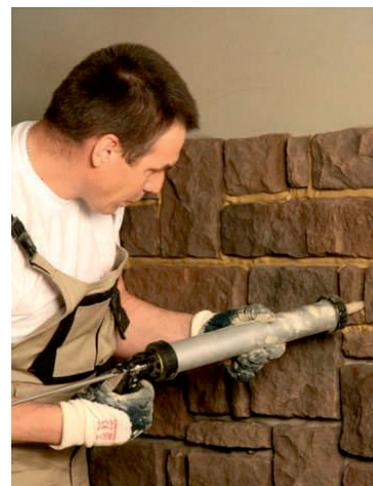
раствор для заполнения швов строго в соответствии с инструкцией по применению. Заполнение швов затирочной смесью осуществляется при помощи строительного шприца-пистолета или специального пакета, обеспечивая сплошное и полное заполнение шва (рис. 7).
