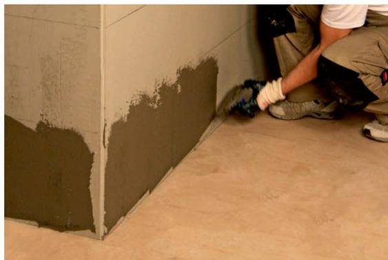
При нанесении клея шпатель необходимо держать под углом 60° к основанию. После этого нанесите клеевой раствор слоем 2-6 мм на тыльную поверхность облицовочного камня, чтобы вся площадь камня была равномерно покрыта клеем (рис. 5).
